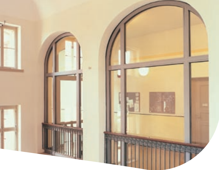
Ecole élémentaire Christburger Straße, Berlin (D) : Mise en œuvre de verres de protection contre l'incendie sur châssis fixe acier avec parties cintrées permettant l'adaptation au style ancien du bâtiment.
