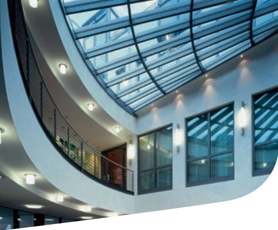
Caisse d'épargne de Starkenburg, Heppenheim (D) : Mise en œuvre de Pilkington Pyrostop™ en toiture (EI/coupe-feu) pour limiter la propagation du feu au niveau supérieur.
