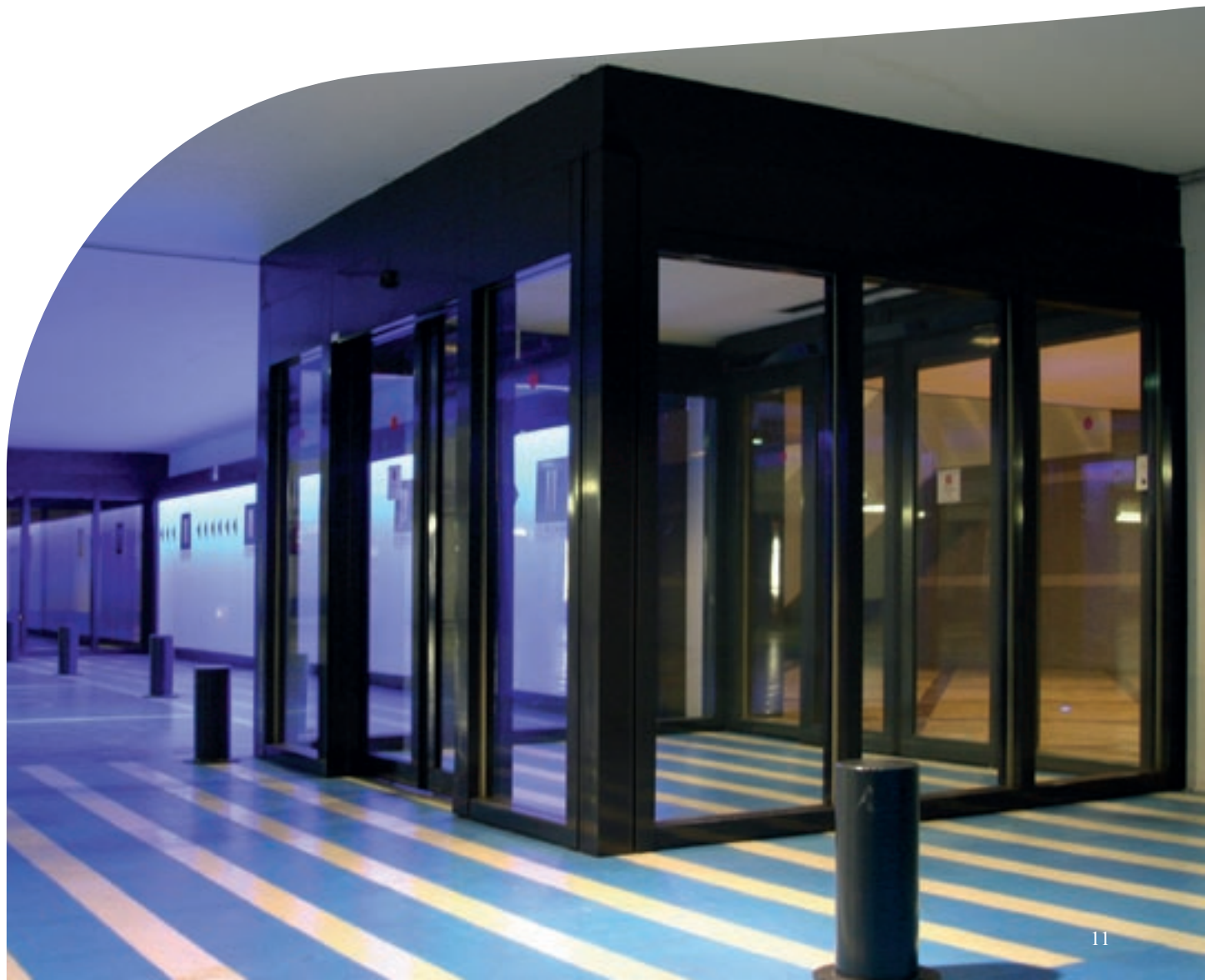
Parking Centre Commercial, Boulogne (F) : Réalisation d'un sas d'accès avec Pilkington Pyrostop™ en châssis fixe acier EI (coupe-feu) 90 minutes et portes coulissantes acier EI (coupe-feu) 60 minutes.
