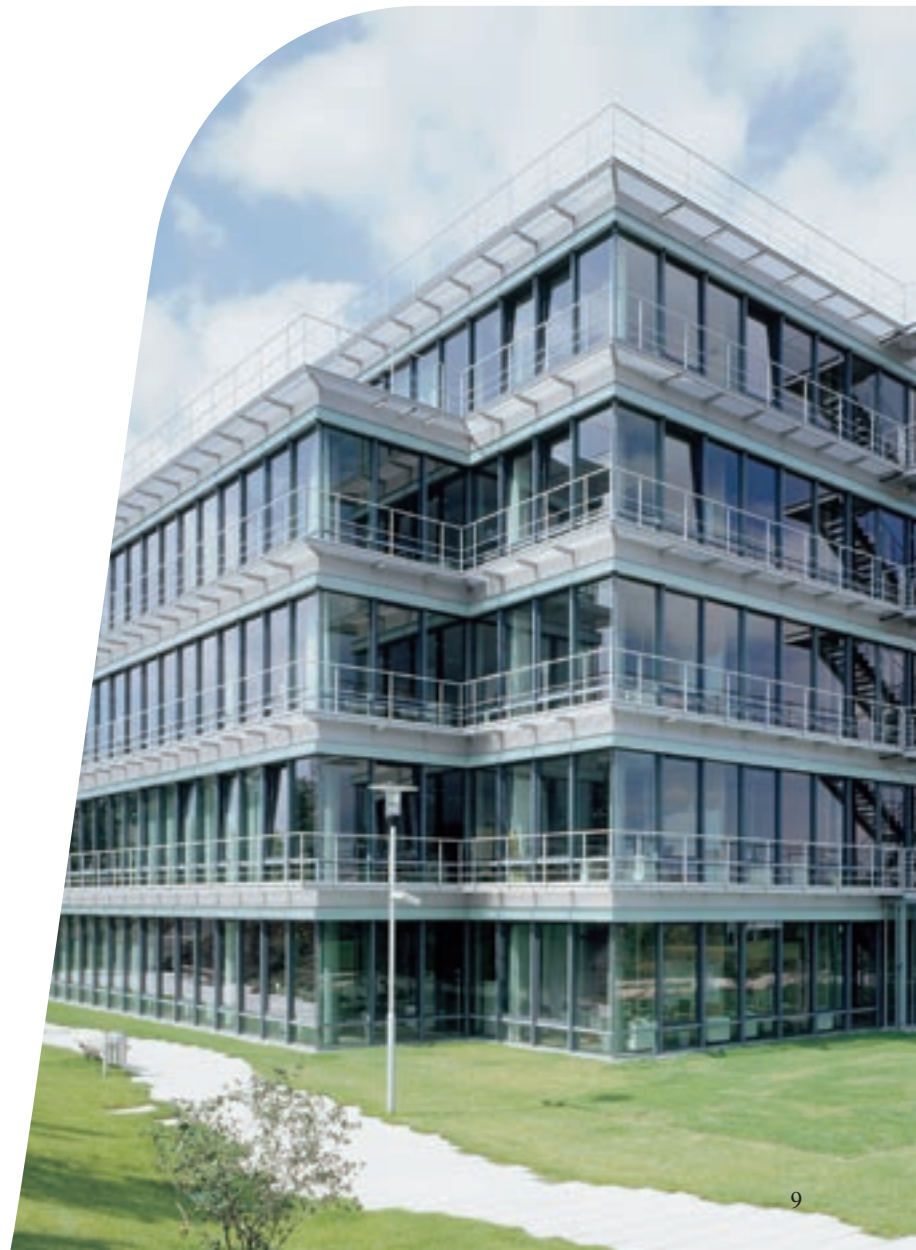
Accenture New Office/Campus de Kronberg, Kronberg (D) : Application extérieure en façade – les performances de protection contre l'incendie de Pilkington Pyrostop ™ sont combinées avec celles d'un verre de contrôle solaire grâce à l'assemblage en vitrage isolant.
