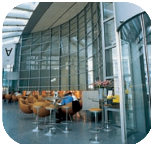
– Image à gauche – Commerzbank (nouveau bâtiment), Francfort (D) : Mise en œuvre de Pilkington Pyrostop™ en cloison (EI/coupe-feu).
