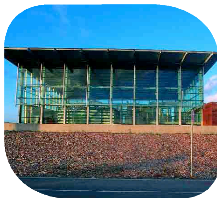
Service de traitement des eaux Sydney, Australie Architecte : Woods Bagot
